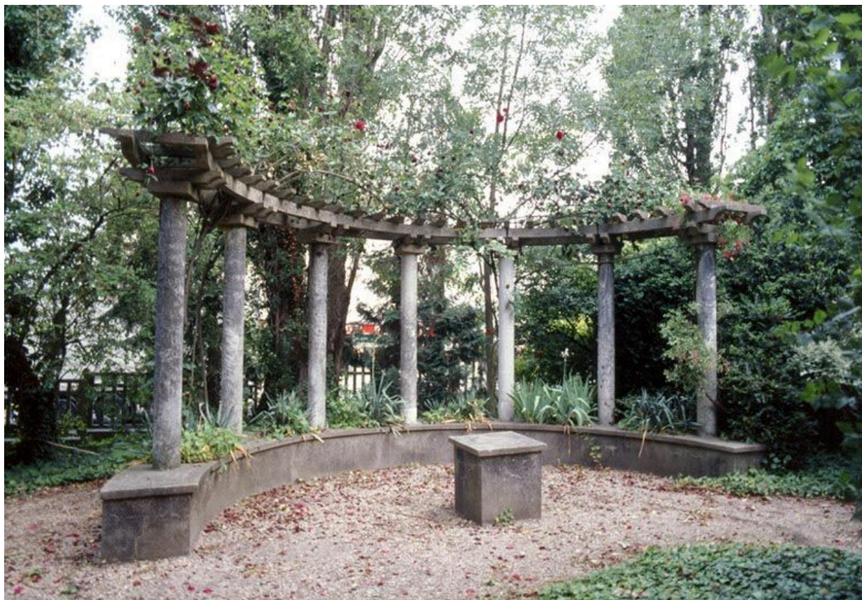
Pergolas de ciment dans le parc de l'hôpital.
