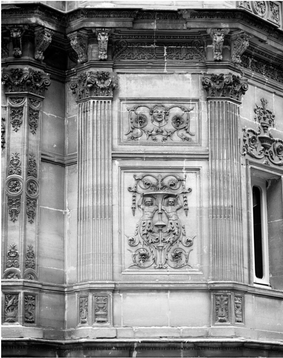
Détail d'un décor sur un panneau du château.
