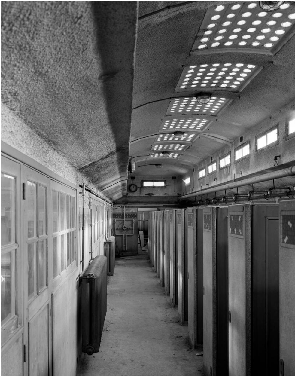
Vue intérieure du couloir des douches, depuis l'entrée. Groupe scolaire, lycée dit école Maurice Payret-Dortail, puis lycée Paul Langevin
