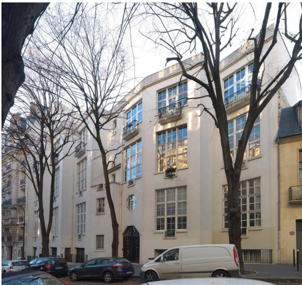
Vue générale de la façade principale, 36 avenue Junot
