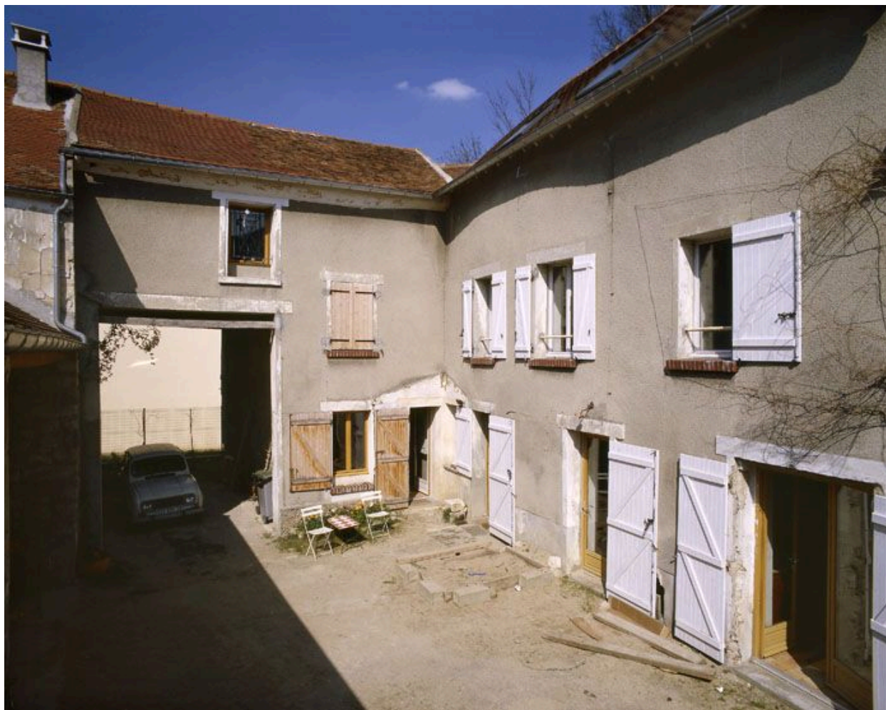
Vue d'ensemble de la cour et d'une ancienne grange.
