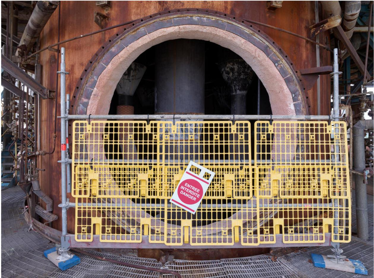
Unités Est - Zone FCC (Unité 651). Porte d'accès à l'intérieur du régénérateur du FCC. Porte boulonnée lorsque l'unité est en fonctionnement.
