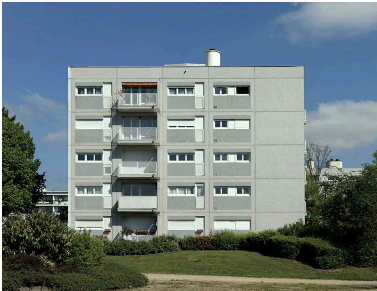
Vue du plot H. façade avec trois type de moduls : balcon sur séjour, fenêtres doubles ( l'une verticale et l'autre en bandeau) pour les chambres, fenêtre en bandeau pour les pièces d'eau.
