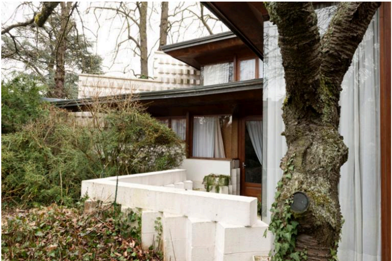
Détail de la façade principale côté gauche.
