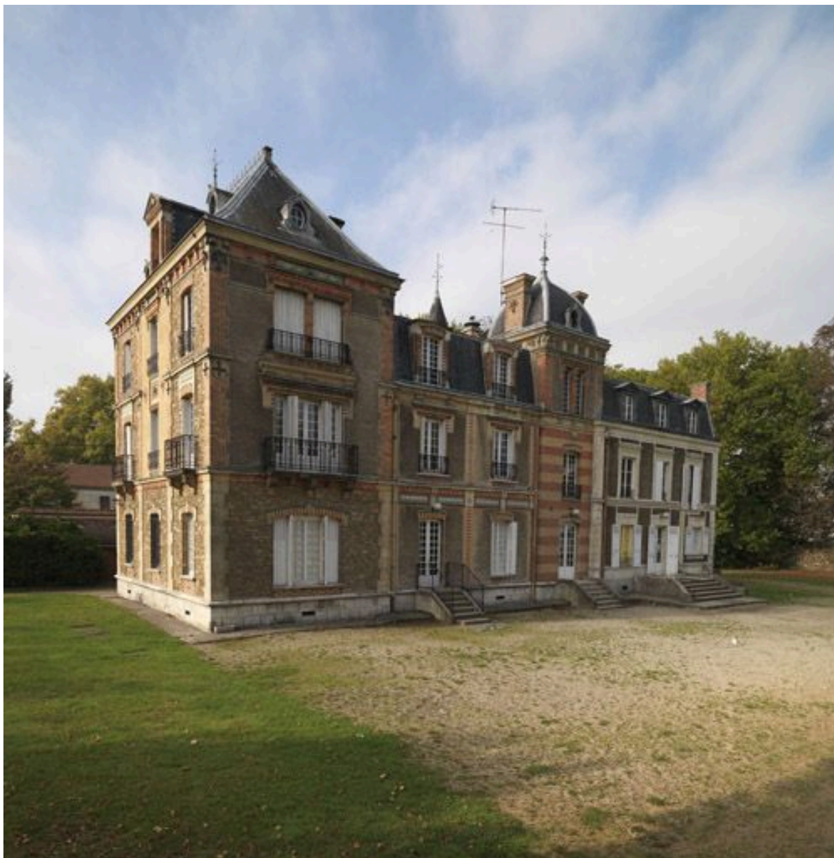
Vue de la façade nord-est.
