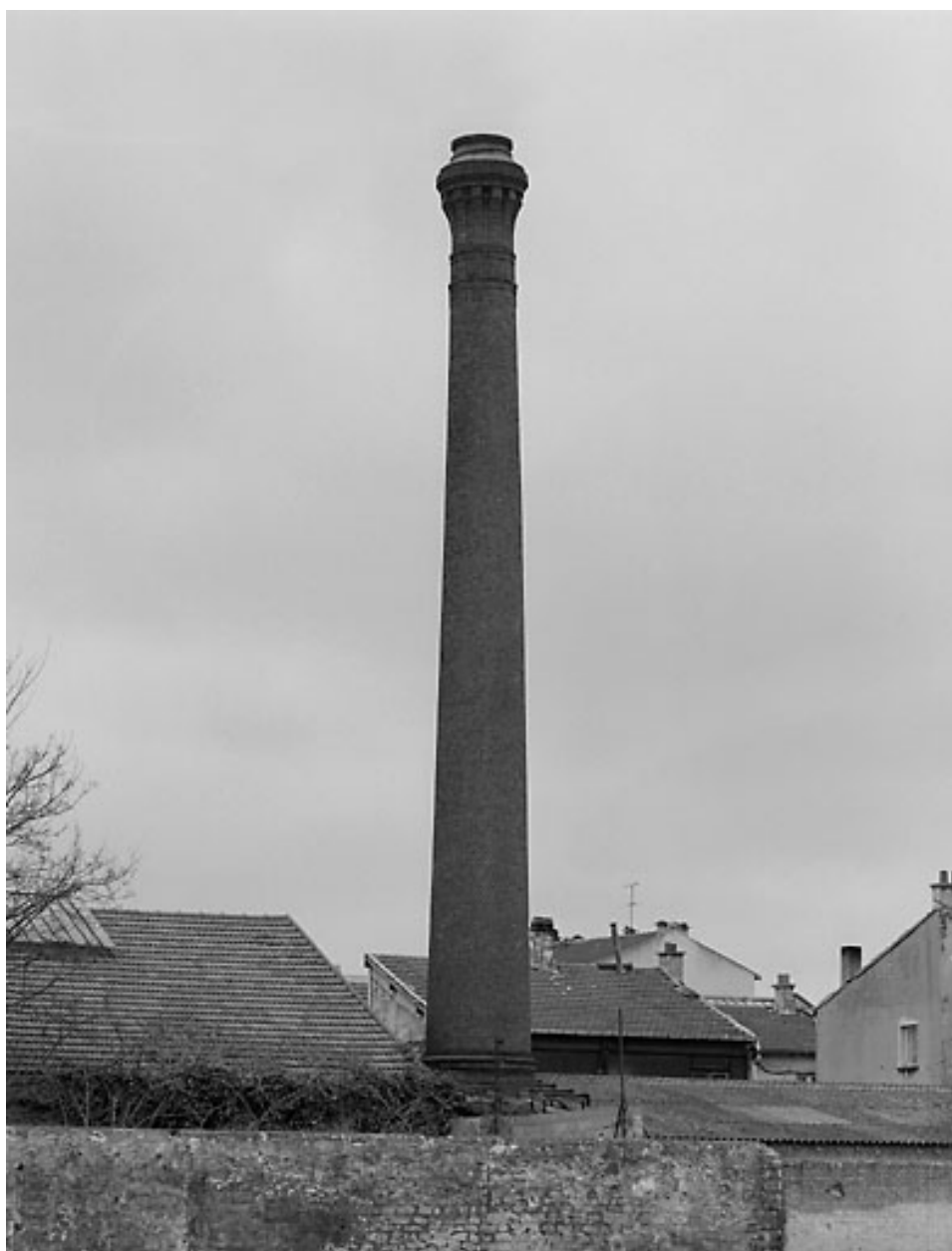
Vue de la cheminée.
