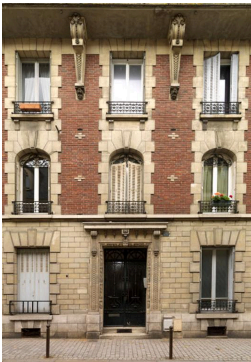
Immeuble aligné , 20, rue de Chanzy. Les travées soulignées en pierre rythment la façade surmontée d'un balcon filant.
