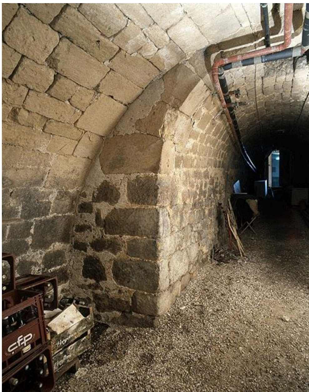
Détail du raccordement entre les deux berceaux du cellier.
