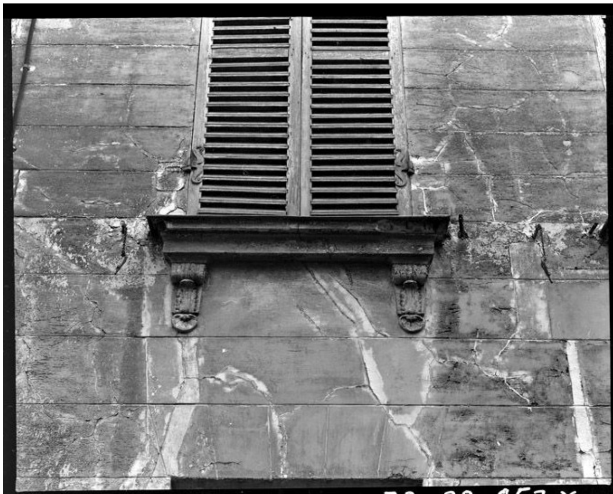
Maison, Colmar (rue de) 11. Détail des seuils de fenêtres soutenus par des consoles.
