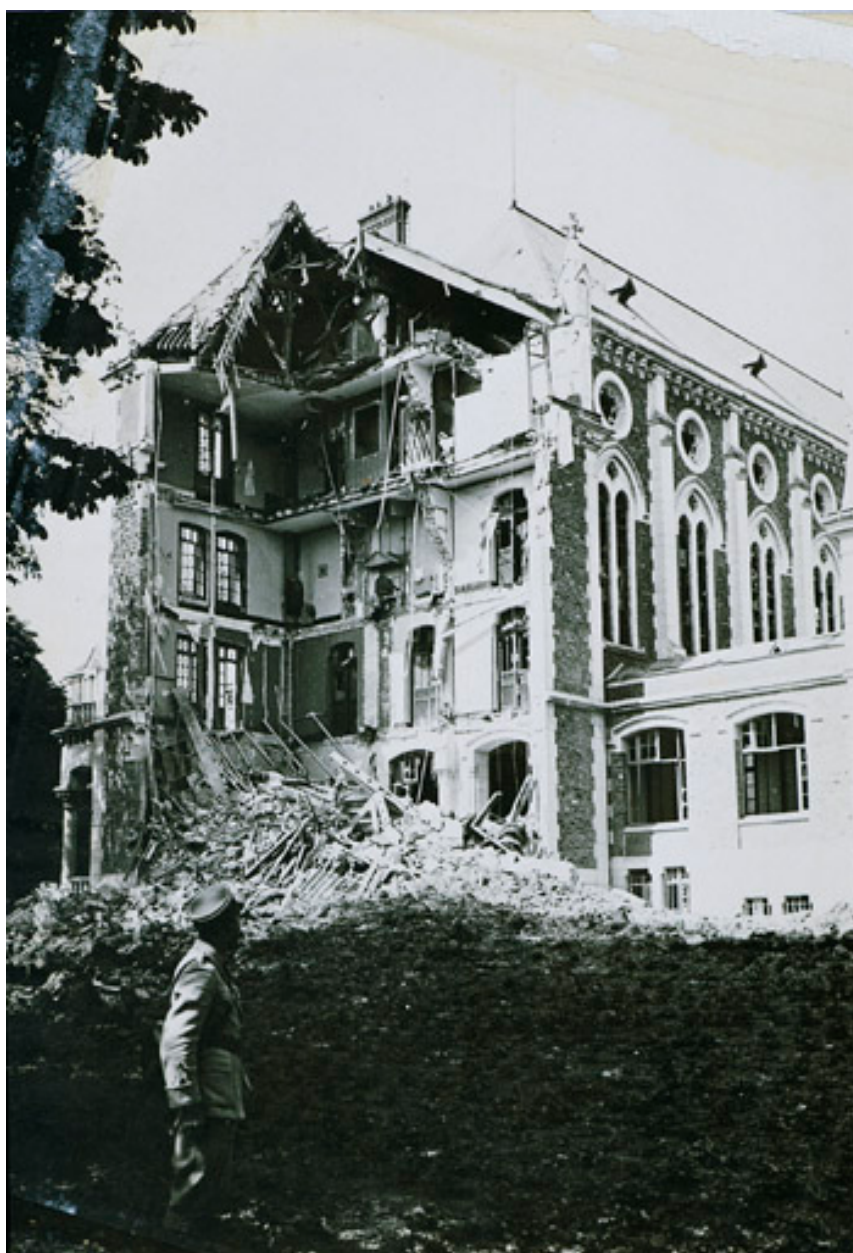
La chapelle endommagée par le bombardement aérien du 29 mai 1944 qui détruit le ""pavillon de tête"" appuyé contre sa façade sud. (AD Essonne, 886 W 44)
