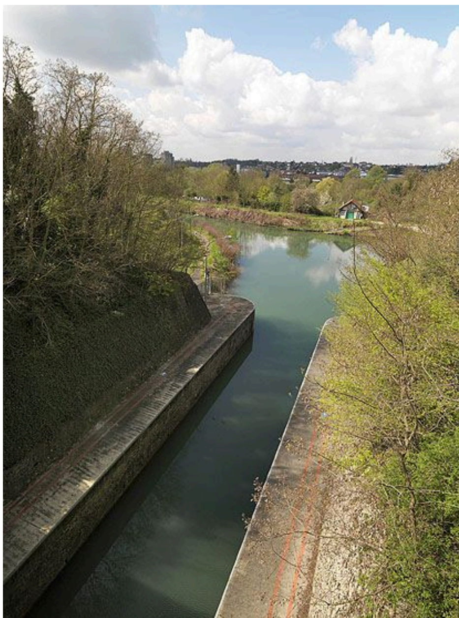
Le canal vu depuis le pont de Chalifert, côté ouest.
