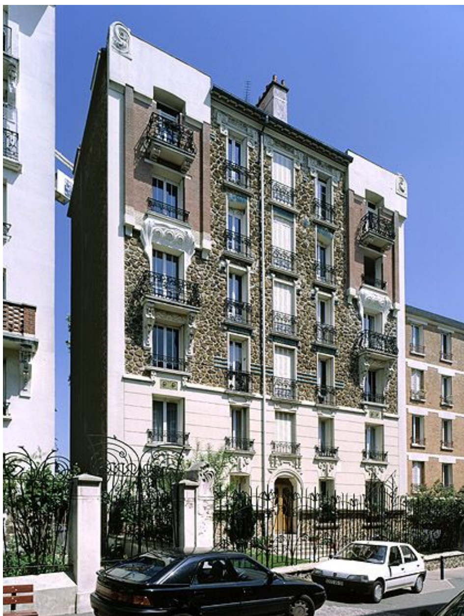
Immeuble, 3 rue Baüyn de Perreuse. Vue d'ensemble de la façade sur rue.
