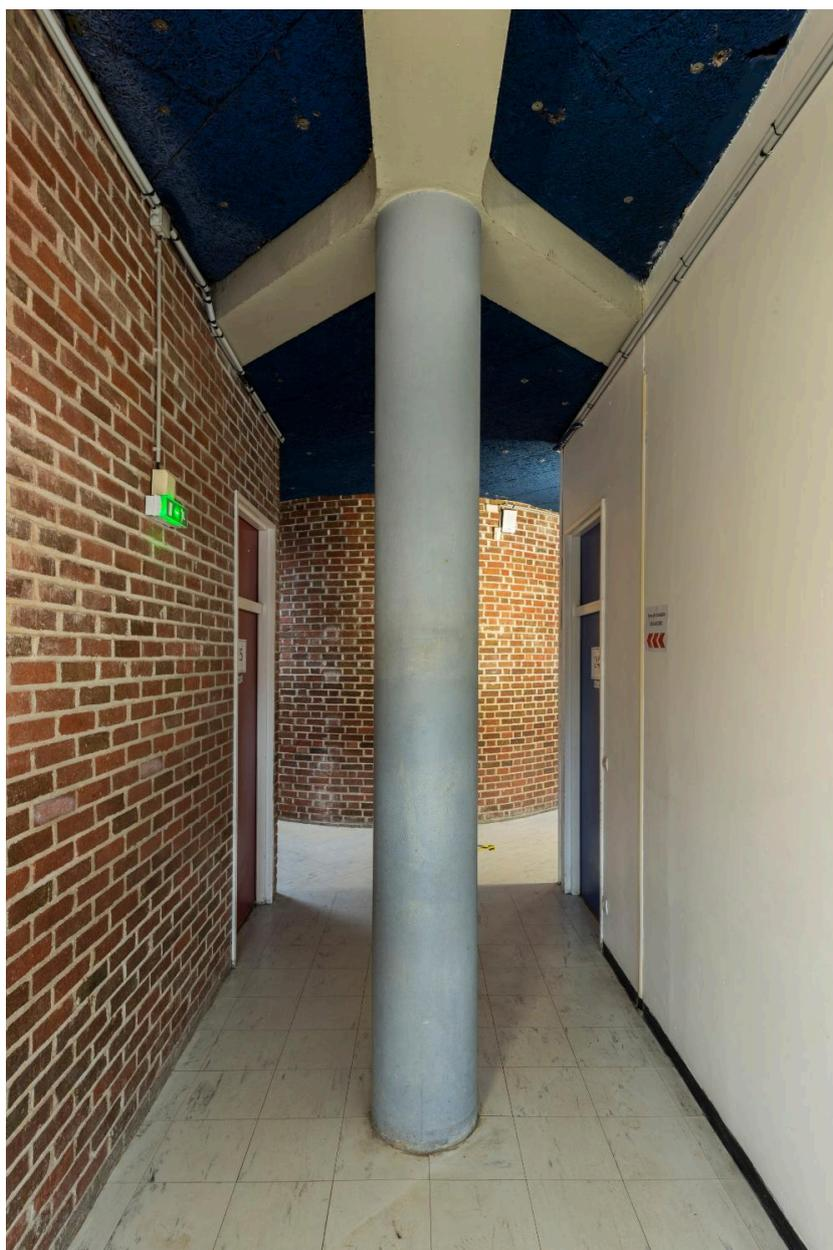
Une circulation, avec la structure poteau-poutre en béton armé apparente.
