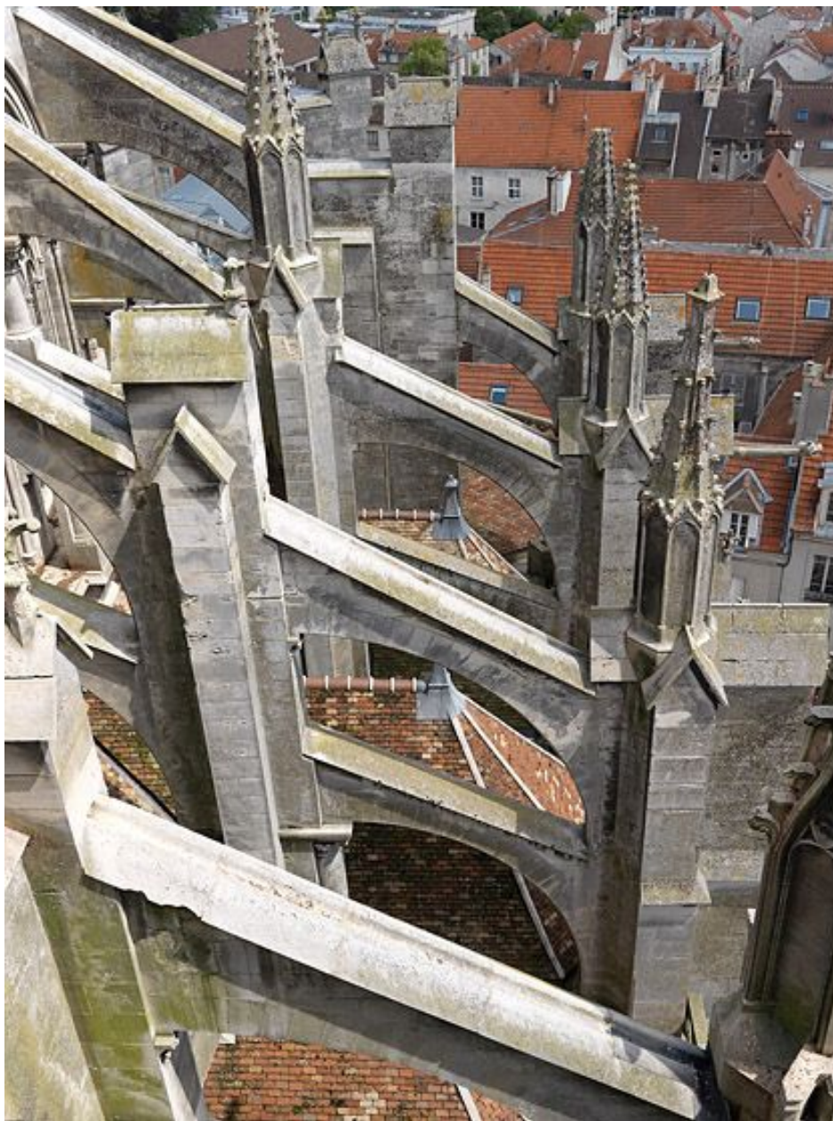
Les arcs-boutants du choeur : détail de la volée extérieure. Vue prise depuis la balustrade sommitale du bras sud du transept.
