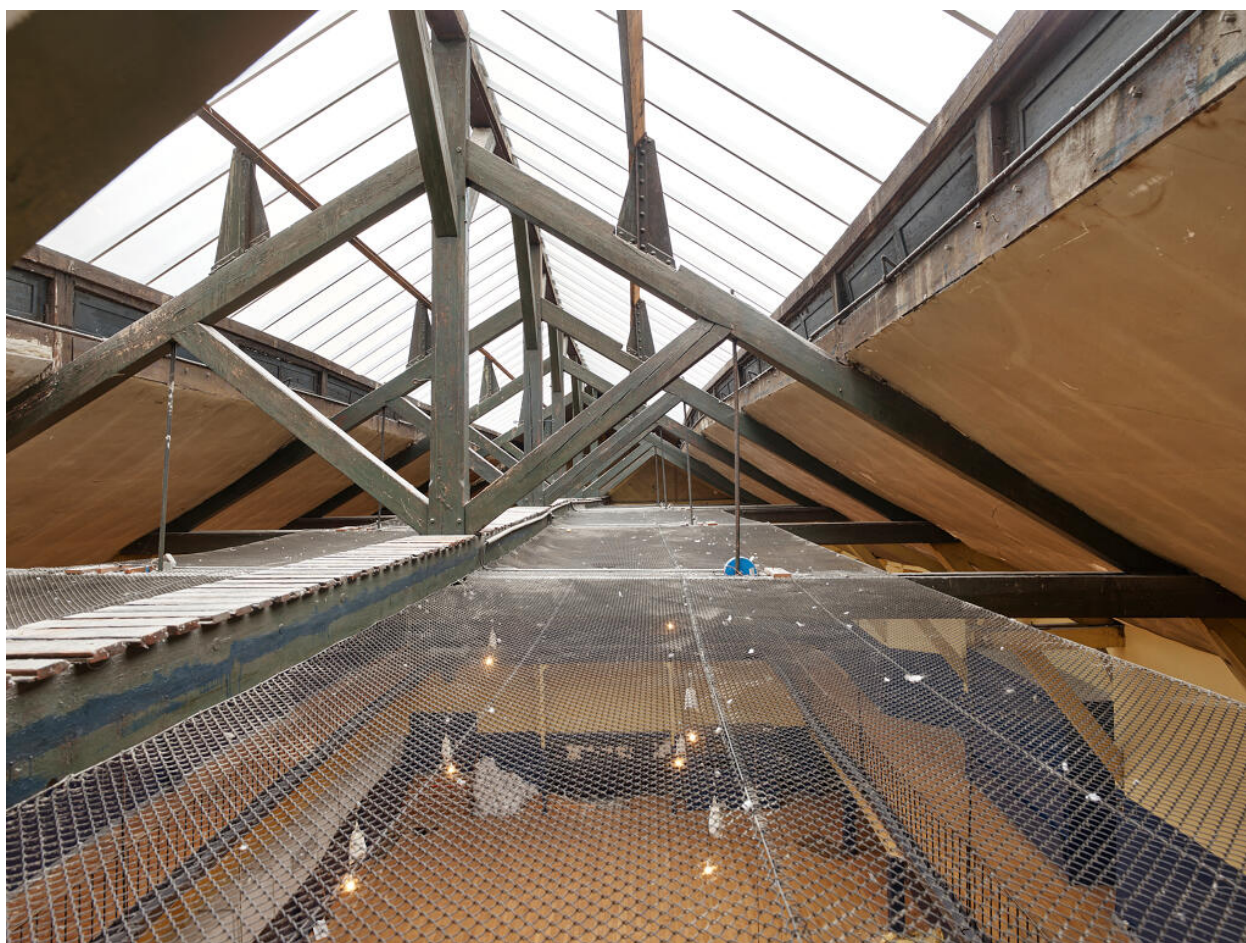
Charpente et verrières de la grande nef du gymnase Christmann
