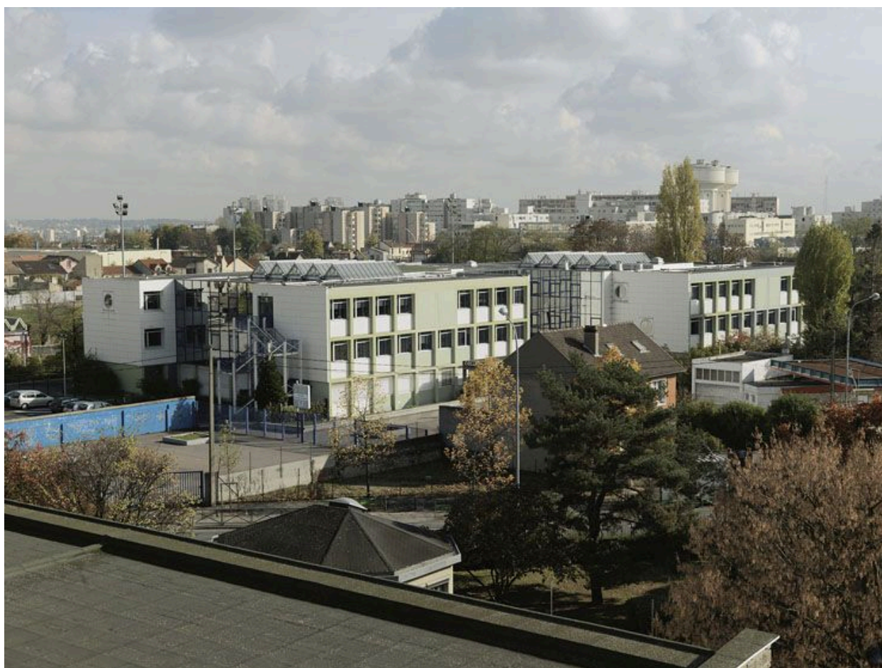
Collège Gustave Courbet, 101 boulevard Henri-Barbusse, réalisé par Paul Chemetov en 1973. Vue des bâtiments depuis les toits de l'école Charcot-Barbusse.
