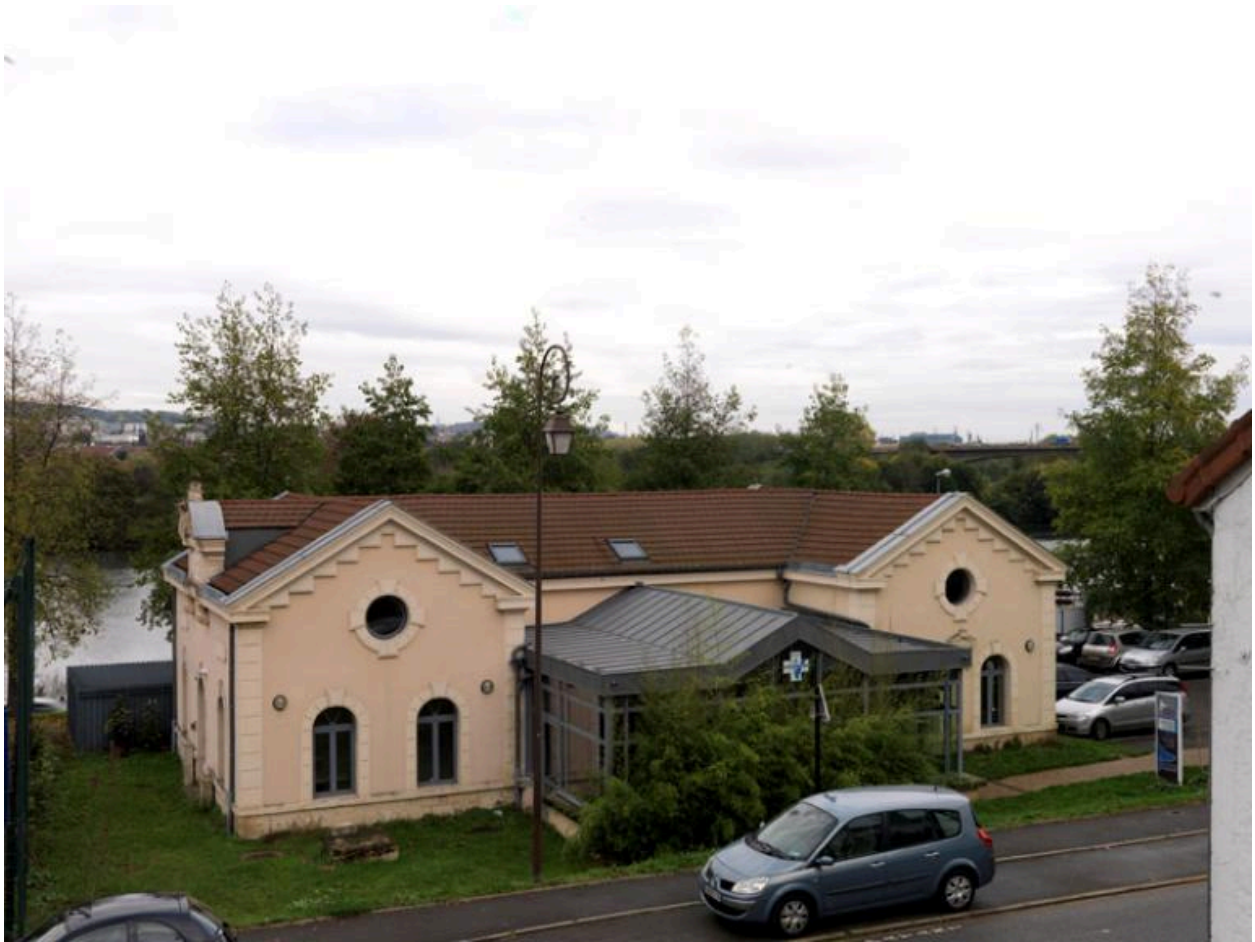
Vue générale et situation de l'ancienne usine élévatoire des eaux de Seine
