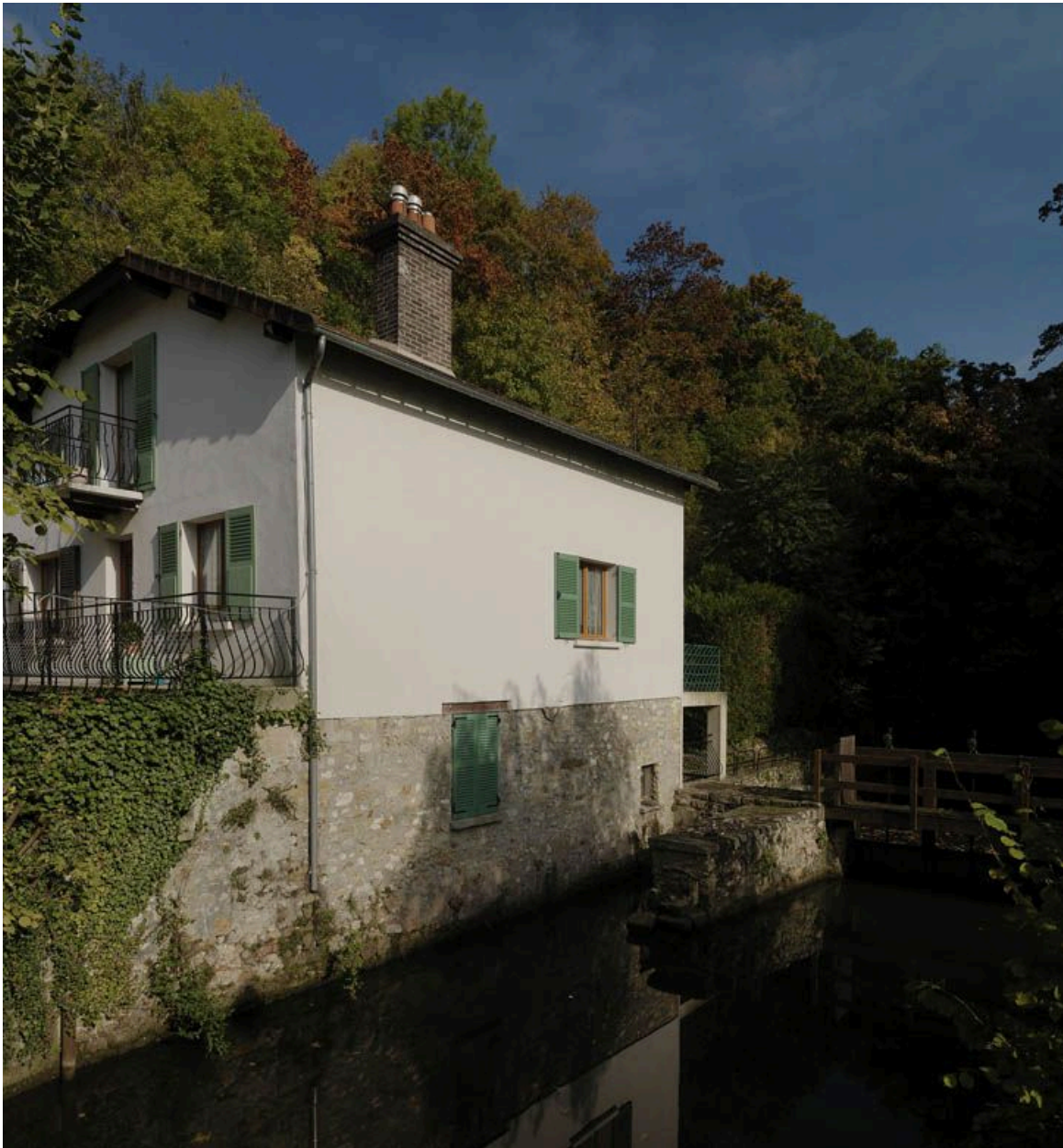
Le moulin bordant le ru du Châtelet.
