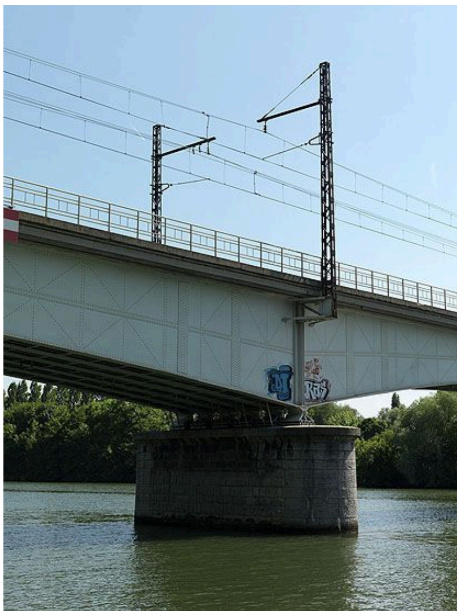
Choisy-le-Roi. Pont ferroviaire de la grande ceinture. Articulation entre la pile et le tablier.
