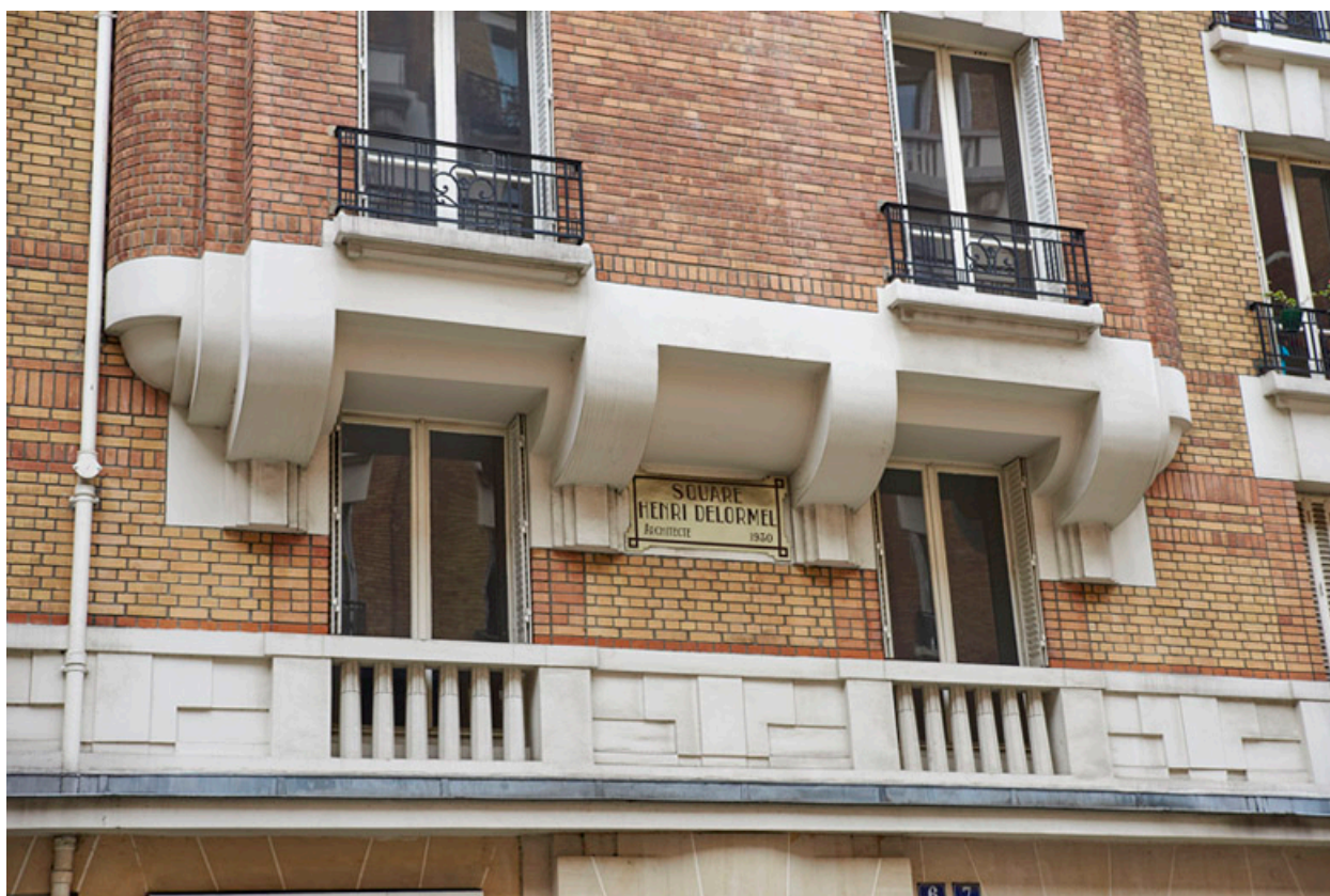
Vue de l'encorbellement d'un bow window
