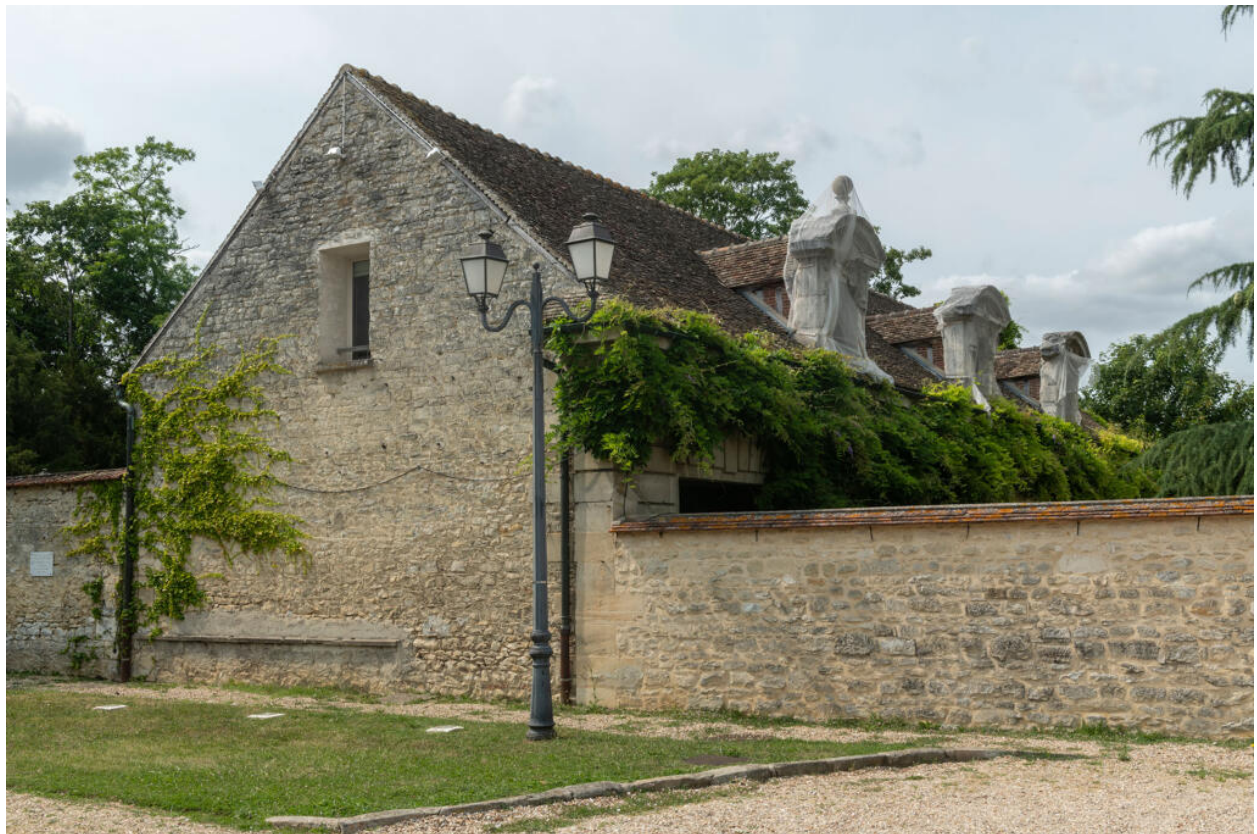
Façade latérale sud du bâtiment agricole.
