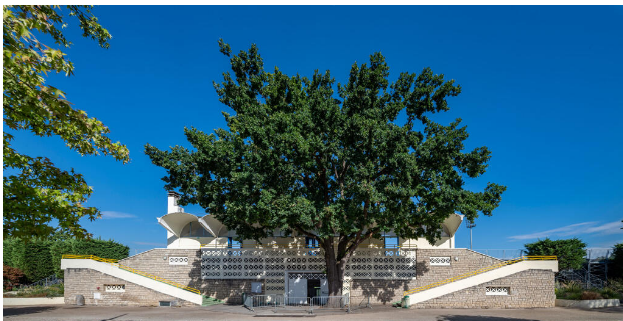
Stade Léo-Lagrange. Façade postérieure de la tribune.
