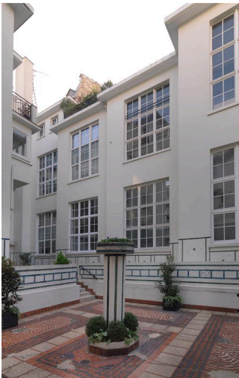
Vue de la cour extérieure séparant le bâtiment B du bâtiment C (3)
