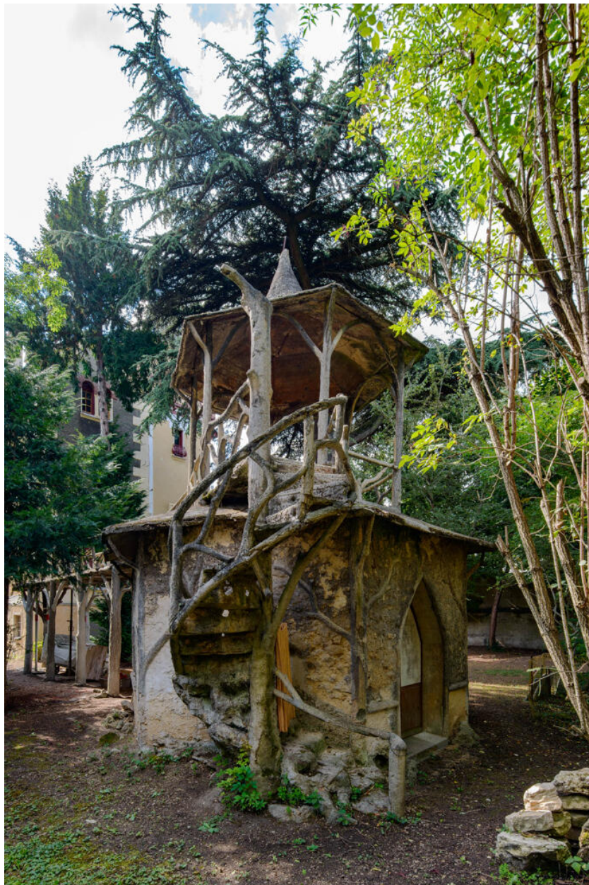
L'escalier du kiosque belvédère.
