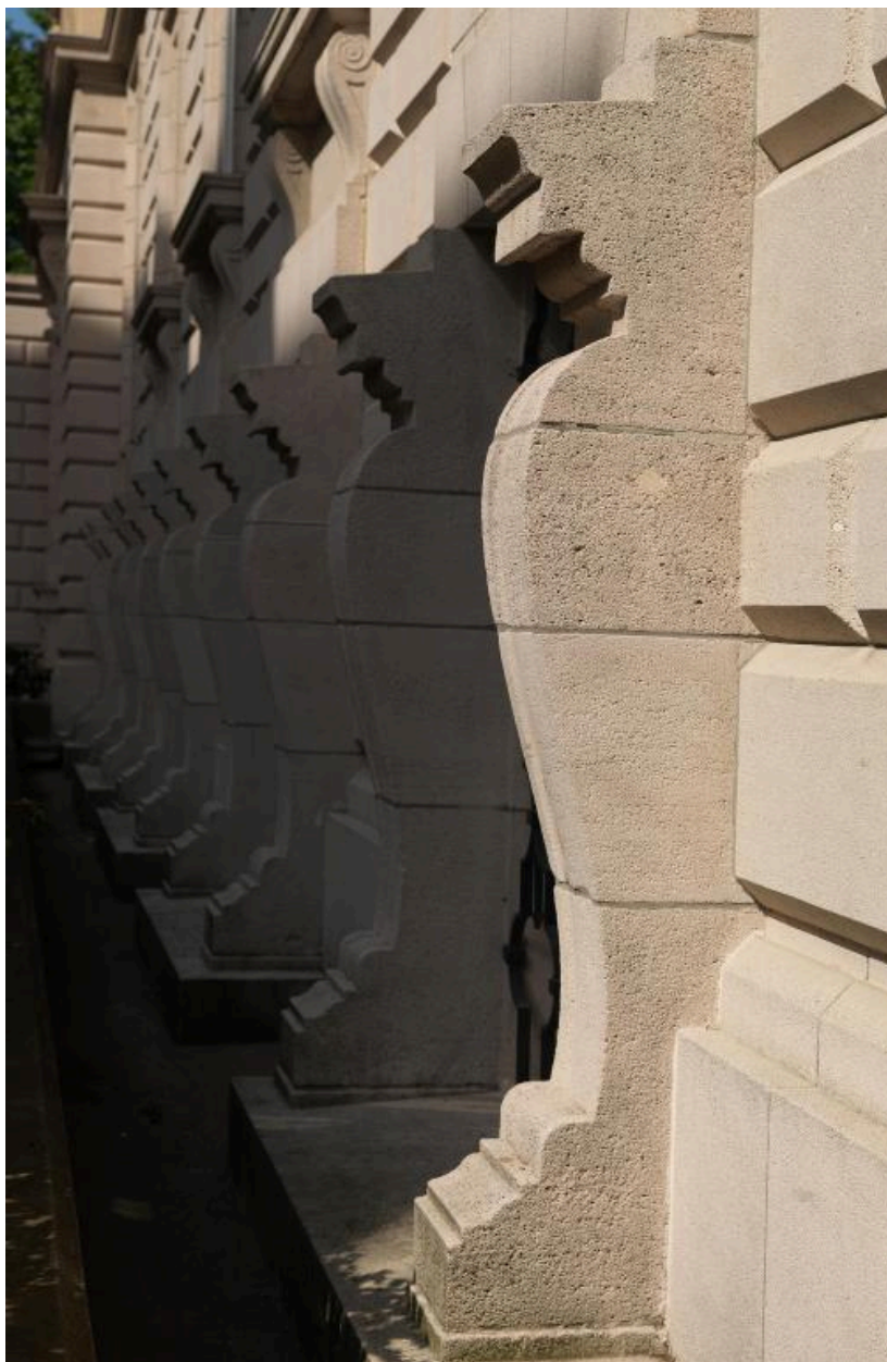
Façade ouest : détail du soubassement.
