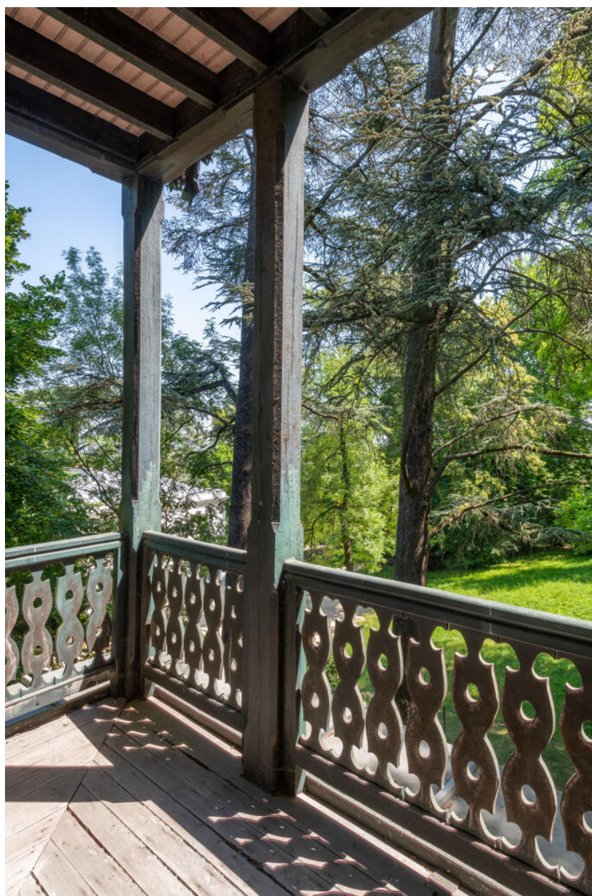
Le balcon de la chambre d'Ivan Tourgueniev, avec vue sur la maison Viardot et sur la Seine au loin.
