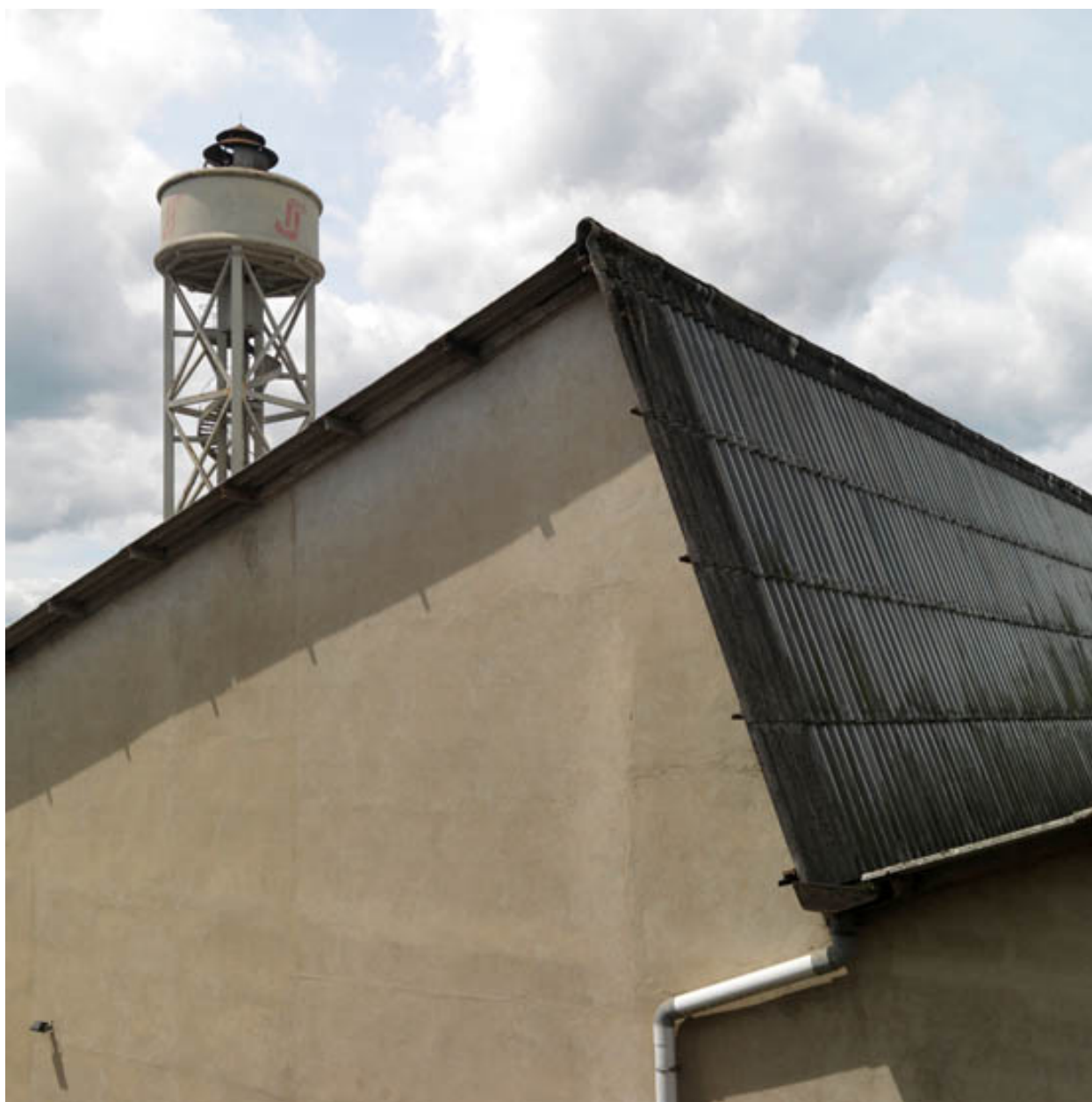
Chateau d'eau (1902). Ciment armé. Au sommet, la sirène installée en 1950 et le logo de la société Jeumont-Schneider.
