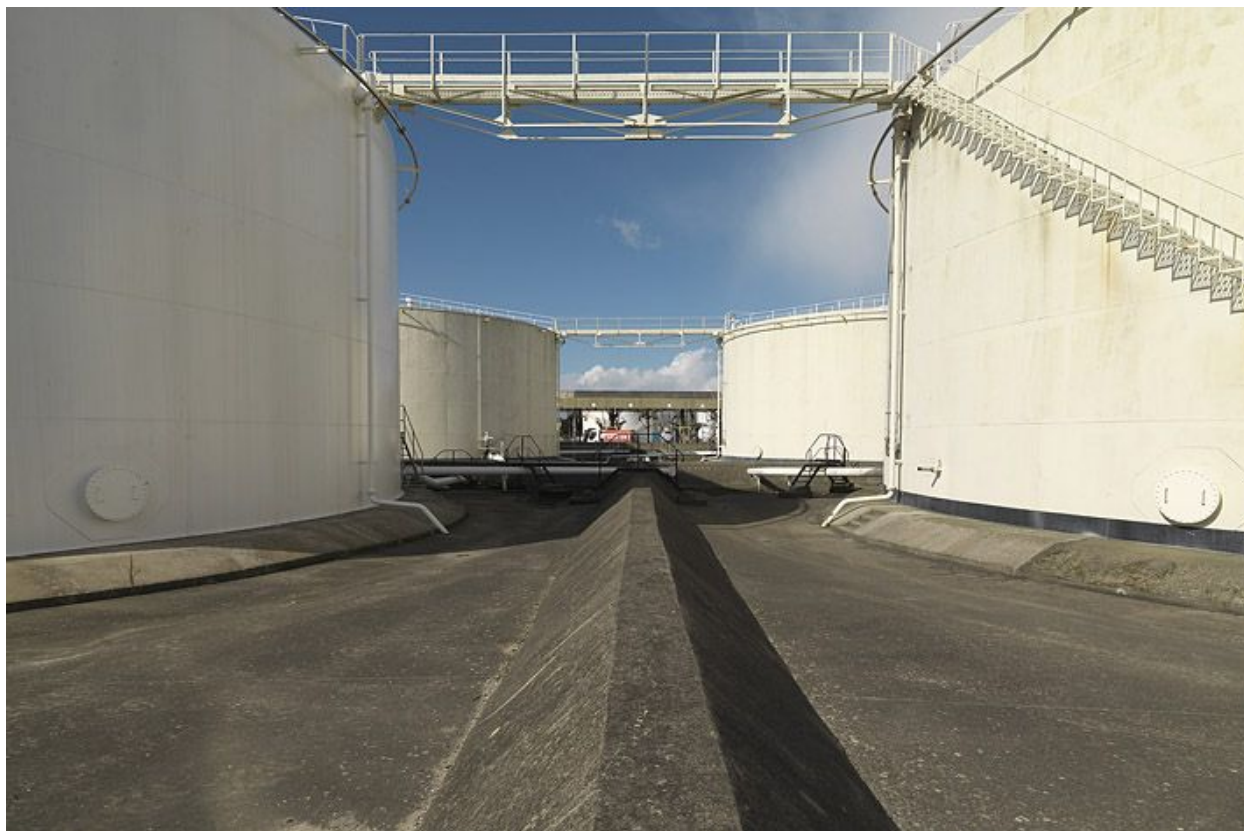
Villeneuve-le-Roi, dépôt pétrolier. Vue de réservoirs.
