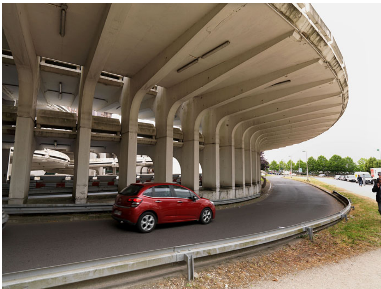
Parking régional du Mont d'Est, 1975-1977. Rampes d'accès.
