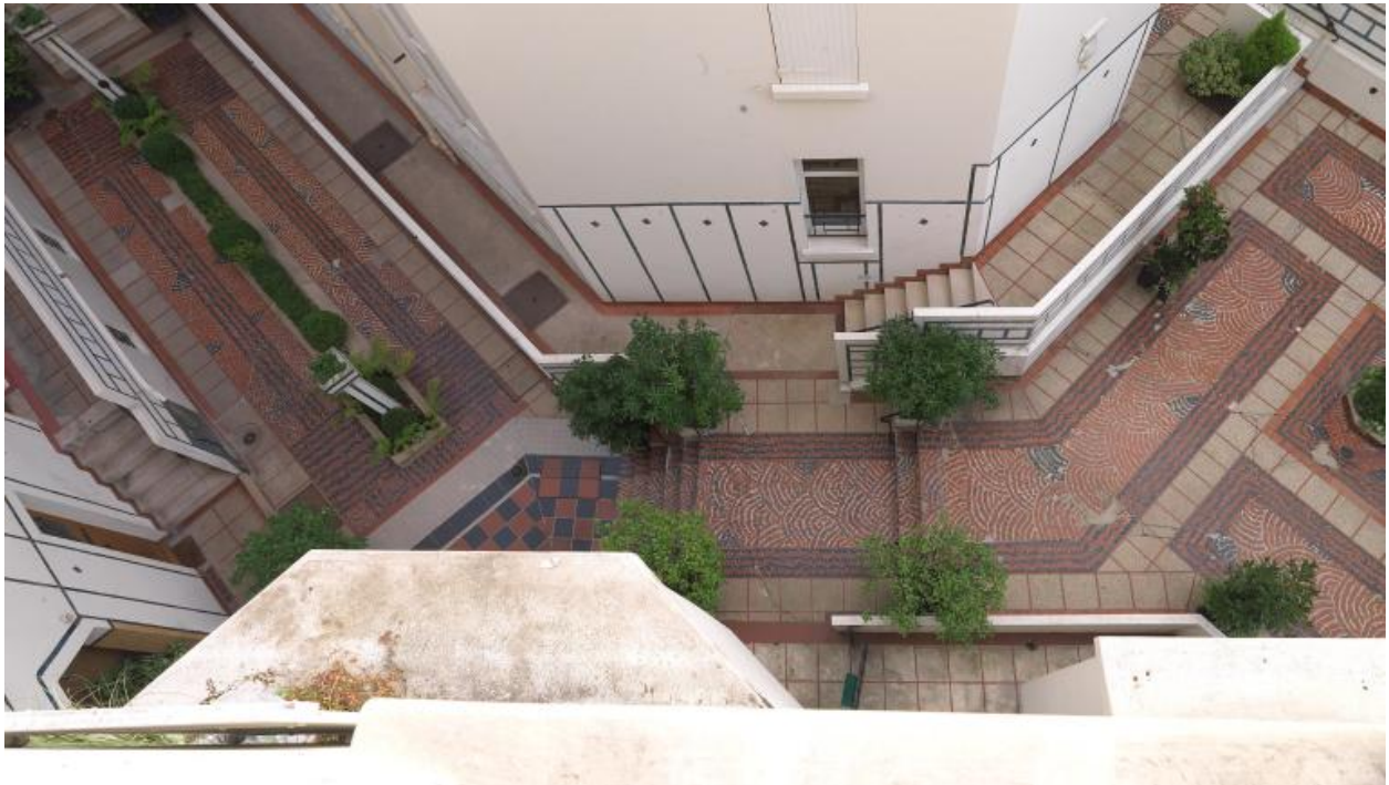
Vue plongeante (première cour, cour des bâtiments A et B) depuis le bâtiment A
