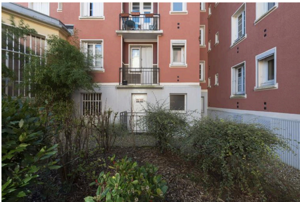
Vue des ateliers situés au rez-de-chaussée (11)
