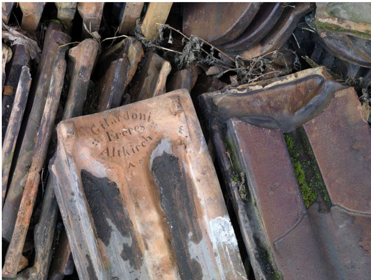
92, Sceaux, lycée Lakanal, 3-7 avenue du Président-Franklin-Roosevelt. Tuiles signées Gilardoni frères Altkirch.
