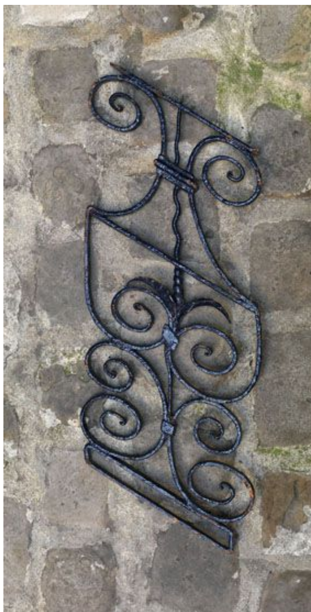
Détail d'un balustre détaché de la rampe.
