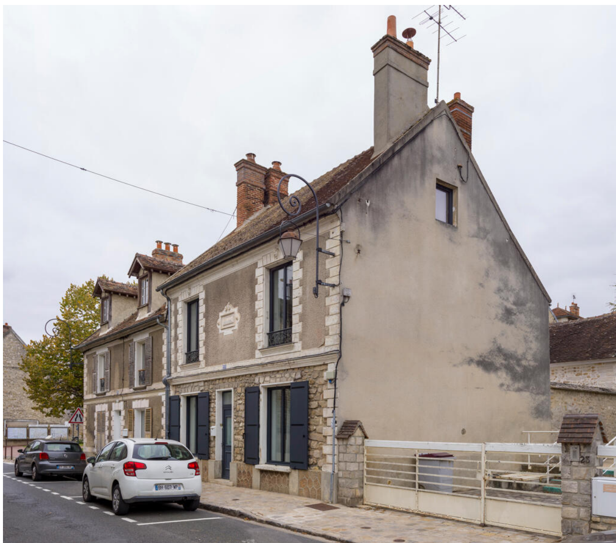
Vue depuis l'angle sud-est de la façade sud.
