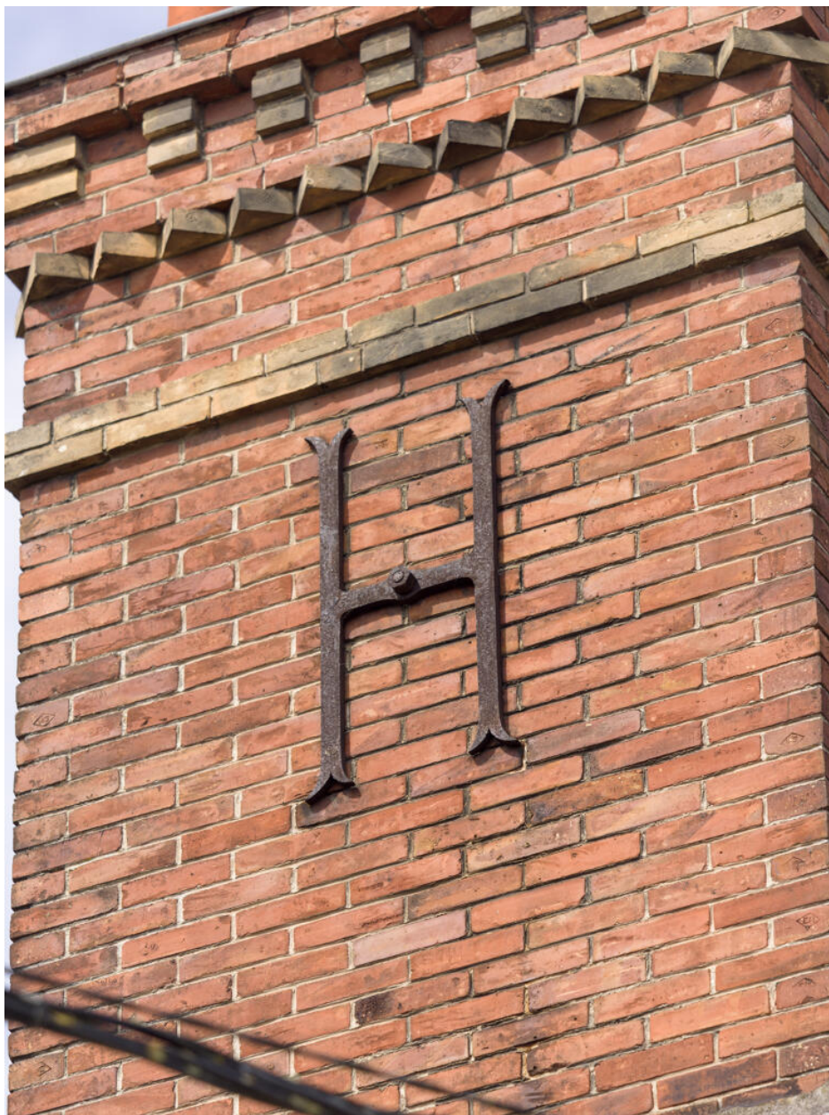
Détail de la souche de cheminée est.
