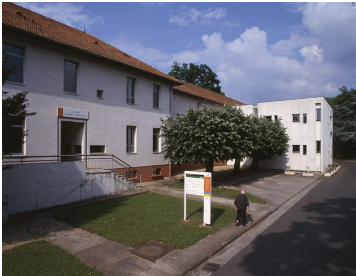
La division Laennec rénovée dans les années 1975.
