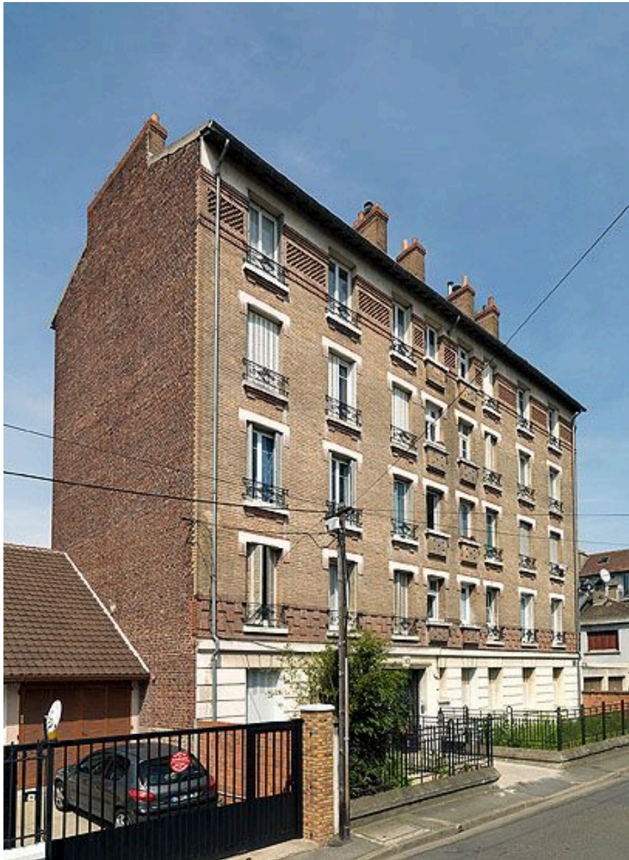
94, Villeneuve-le-Roi, immeuble, 113 rue de la Gare. Vue de la façade sur rue.
