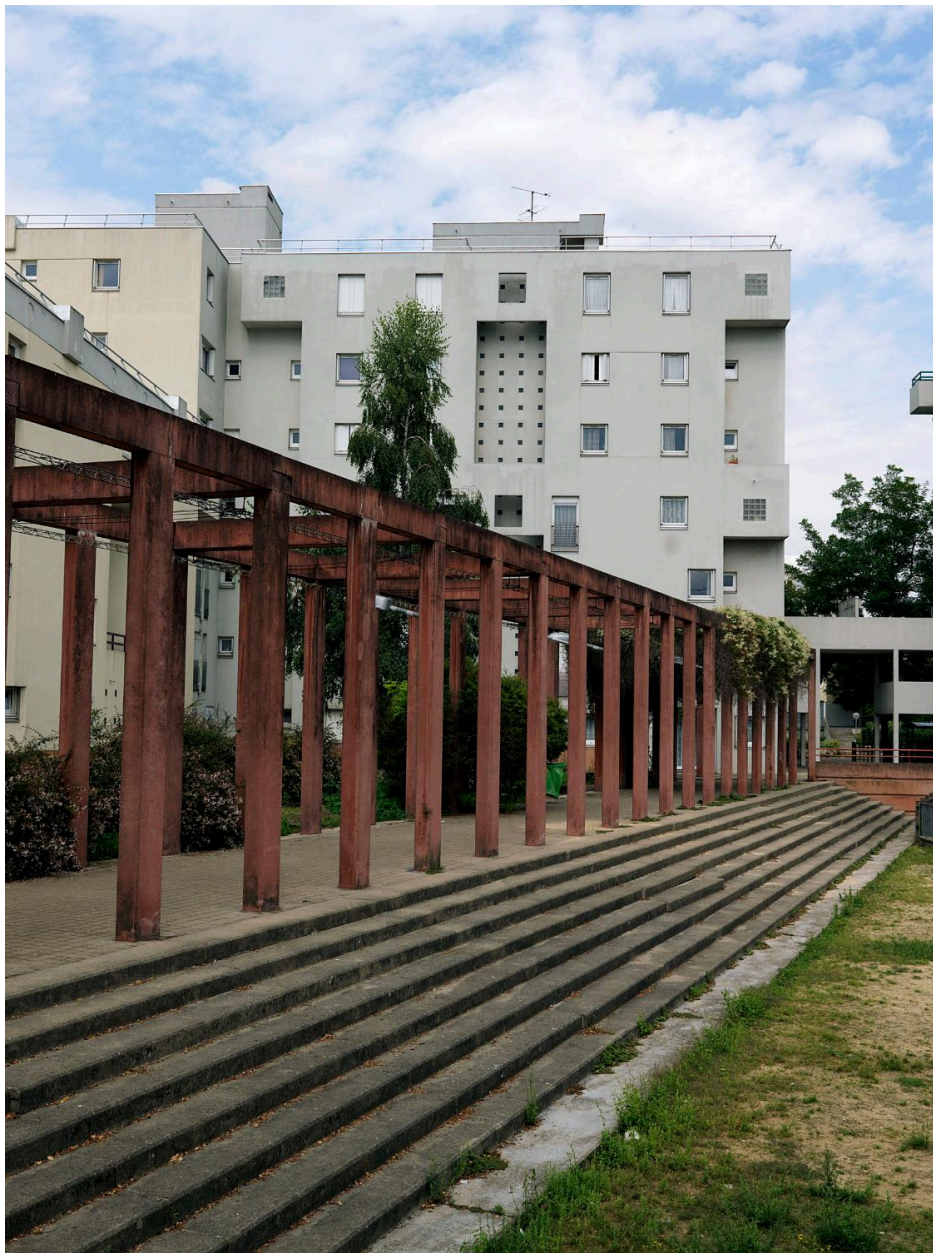
Cité Pablo Neruda. Circulation extérieure, aménagée entre les bâtiments : portique.
