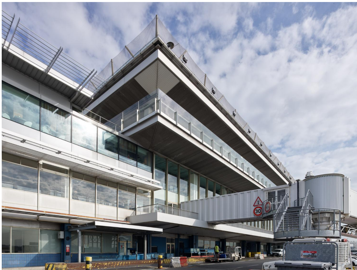
2018, Orly-Sud: le corps central et la jetée ouest vus depuis le sud ouest.
