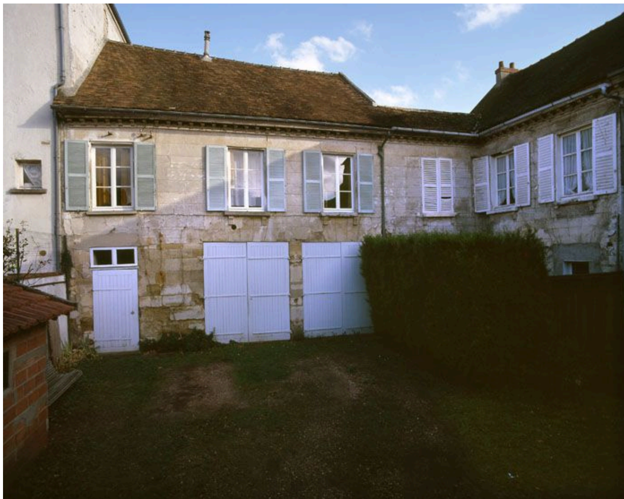
Vue d'ensemble de l'aile gauche qui abritait les communs.
