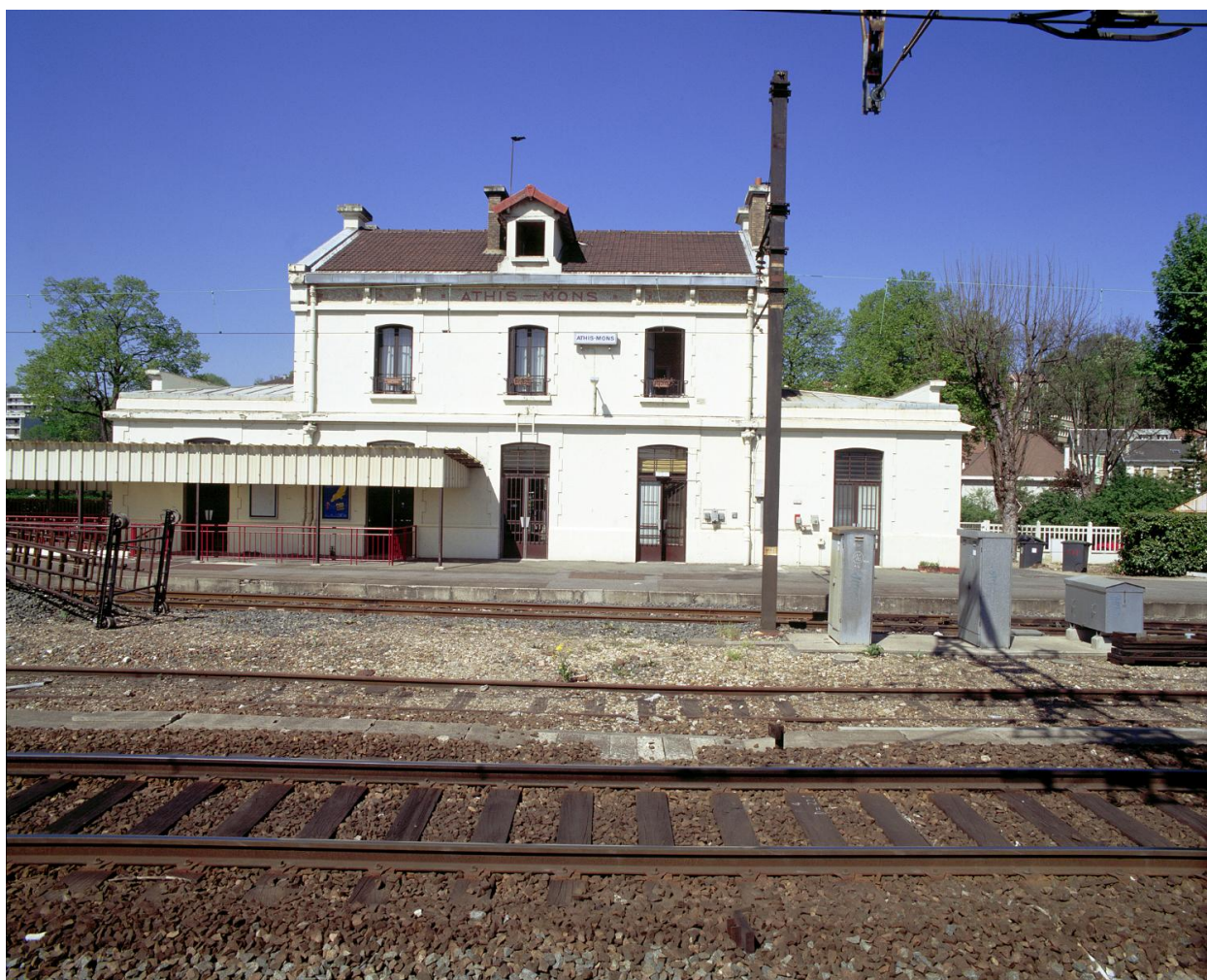
Façade postérieure (côté voies ferrées).
