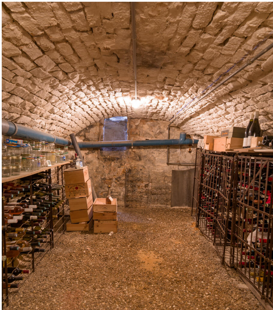
La cave, vue depuis le nord.
