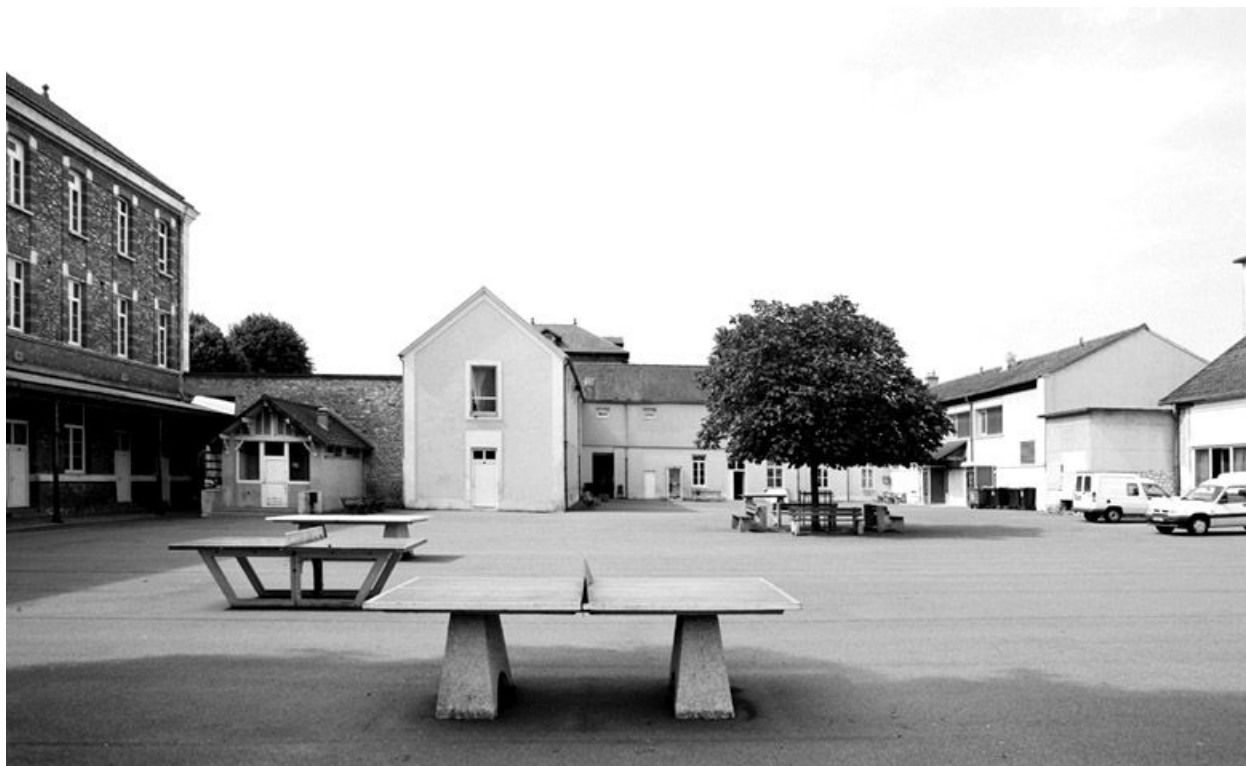
Cour à l'arrière du "'Petit Quartier'", vue du nord.
