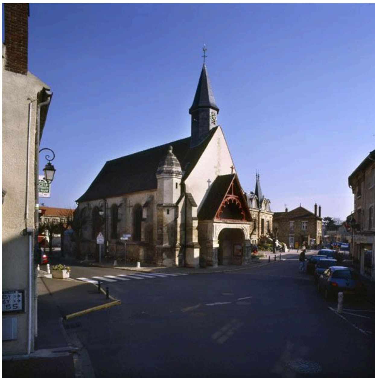
La façade principale et le flanc nord.
