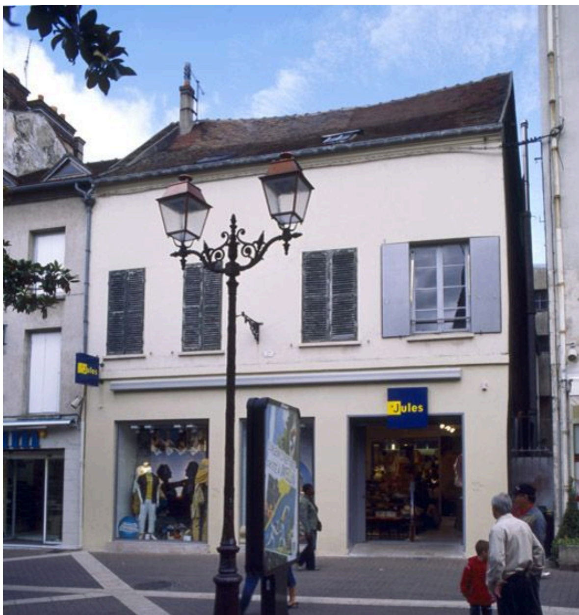
Vue de la façade.
