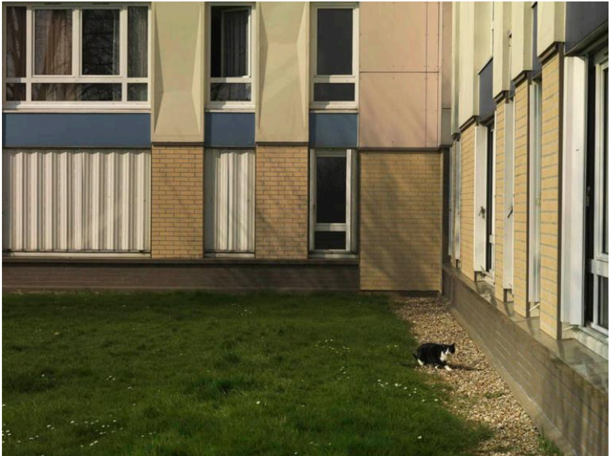
Façade et soubassement d'un immeuble après rénovation.
